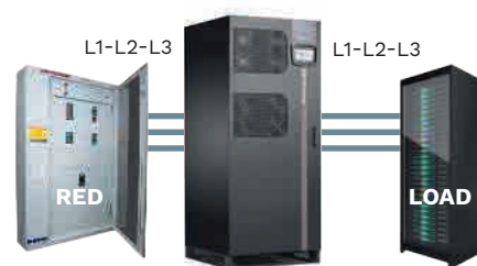
instalación de 3 conductores (L1-L2-L3)
